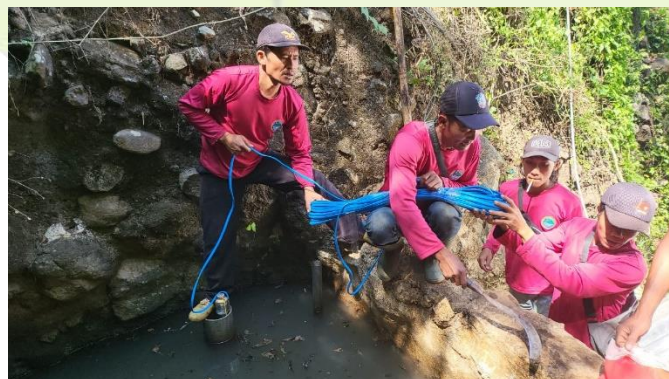
Gambar 4. Pemasangan Pompa oleh Tim Pelaksana Program Kemitraan Masyarakat Sumber : Dokumentasi Penulis (2022)
