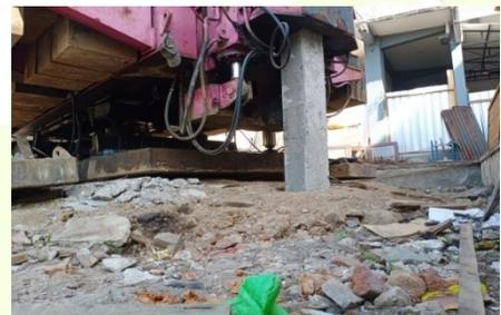
Gambar. 1 (a) proses membawa tiang pancang ke titik yang akan ditanam pancang; (b) proses tiang pancang di tanam ke titik yang sudah di tentukan
