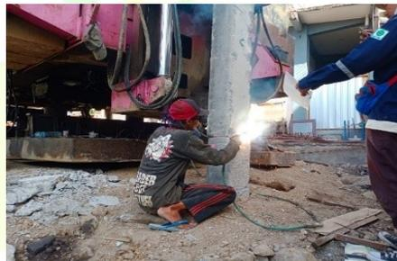
*Gambar. 6 pekerja tidak menggunakan APD lengkap saat proses pengelasan atau penyambungan tiang atau pipa pancang*
